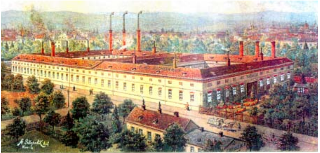
ANSICHT DER FABRIK IN WIEN, XIII, EITELBERGERGASSE 6—14.
